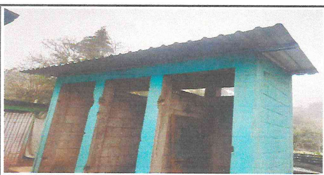
Foto 5: Techo de los baños
