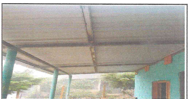
Foto 6: Techo de la cocina
